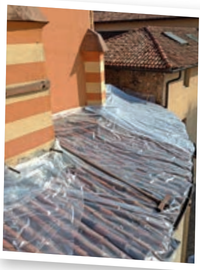
L'intervento alla copertura delle navate laterali della Madonna
